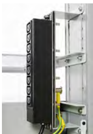
Integrierte Netzschiene zum einfachen Anschliessen der Gerätschaften plus POAG
